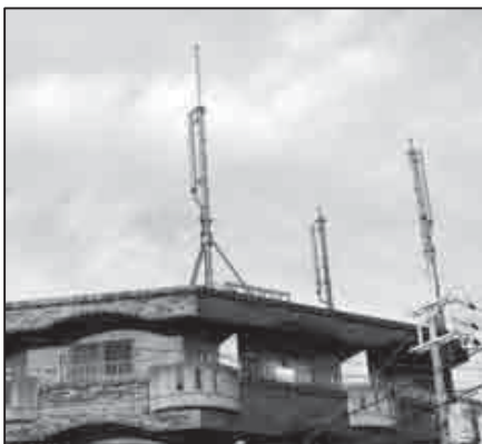
3 階建てマンション屋上（伊丹市）
