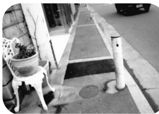
電柱が撤去された歩道
