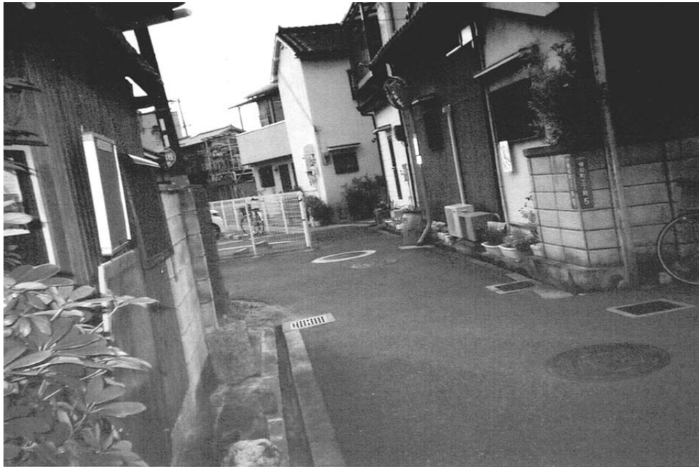
道路幅が狭く、歩道もないのに、抜け道として交通量が多い。
